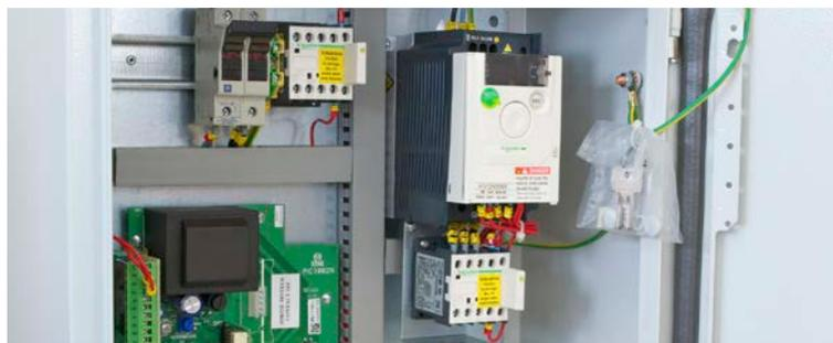
Contacteur de pilotage du frein monté sur rail DIN.
